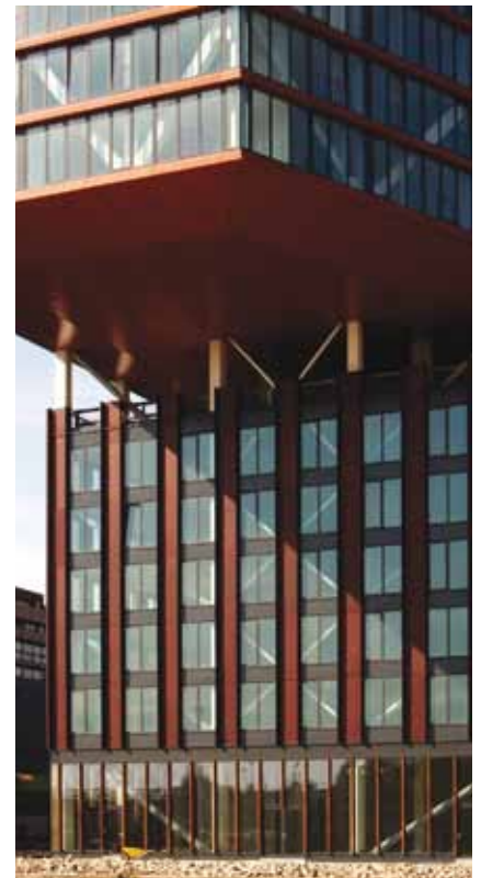
Der obere Teil des fünfeckigen Kopfgebäudes schwebt als freitragender, auf Stelzen ruhender Ausleger, scheinbar losgelöst über der "Basis".
